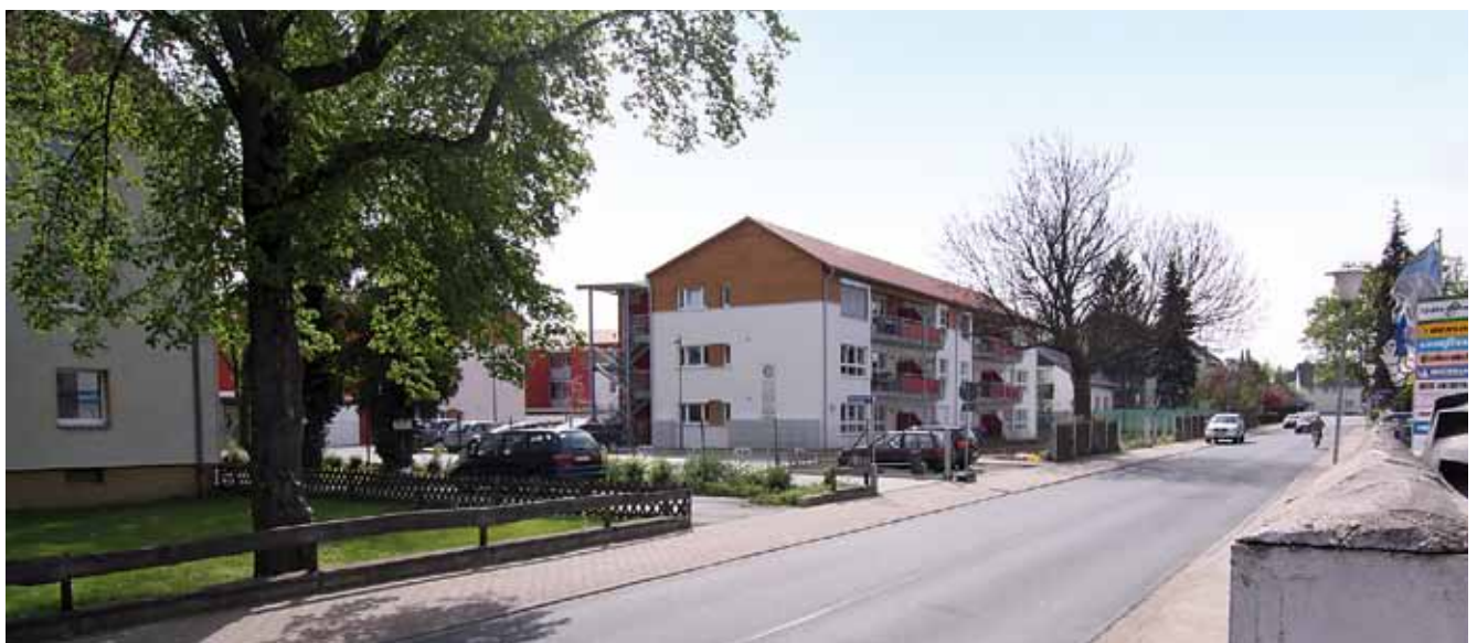
Neubau 12 WE Grauhofstraße 21.
